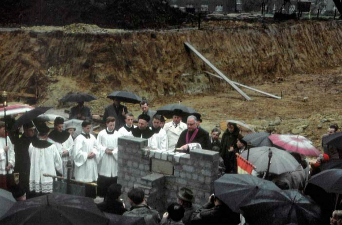
Grundsteinlegung Neubau Bauteil A, 1983
